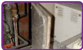
Conduit amiante-ciment
